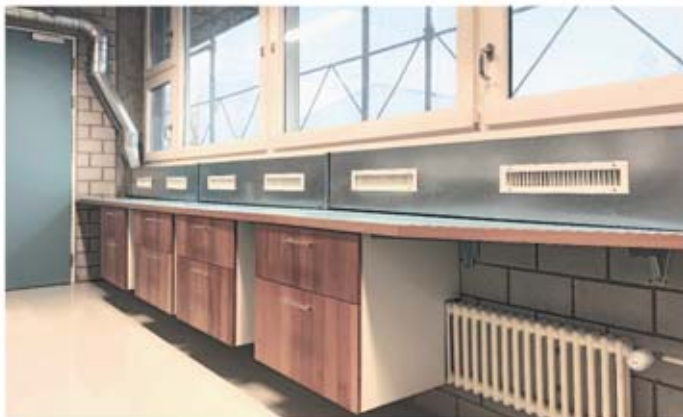
Farbmischraum mit Absaugsystem auf der Arbeitsfläche.
