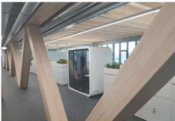
Bei der Büroaufstockung der Holzkraftwerk Basel AG überbrücken Fachwerkträger aus Stabschichtholz Buche eine statische Länge von 35 Metern.
