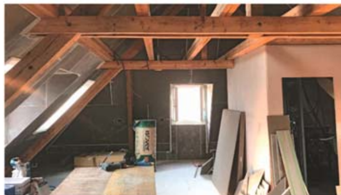
Ein Dachstockausbau wie in diesem Patrizierhaus von 1924 ist das ideale Einsatzgebiet für die Riduro® Gipsplatte: imprägniert, faserverstärkt, kartonummantelt und zu verarbeiten wie eine normale Gipsplatte.
